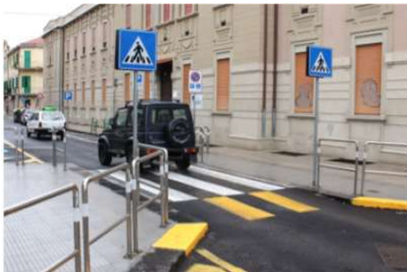
Fig. 1.b – Zona 30 in corrispondenza della scuola “Verona Trento”.
